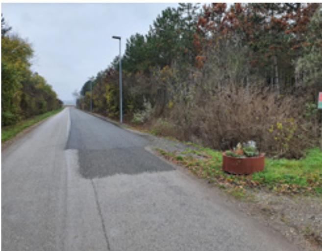
Spritzasphalt wurde entlang des Windschutzes sowie zwischen Föhrenwald und Föhrengasse aufgebracht, damit wurde der lose Untergrund gebunden.
