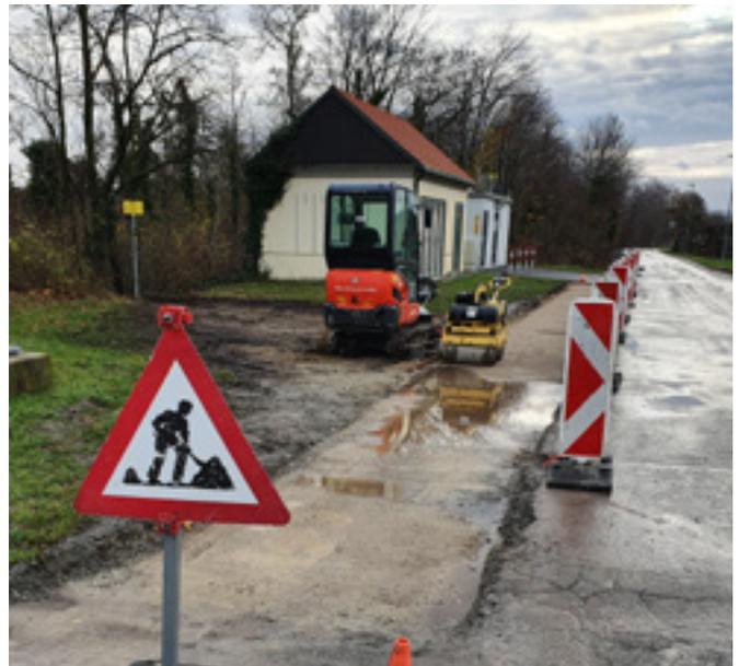
Am Eisteich wurde auf Höhe des Biotops der lose Untergrund durch eine tragfähige Schicht ergänzt und die Asphaltfahrbahn verbreitert.
